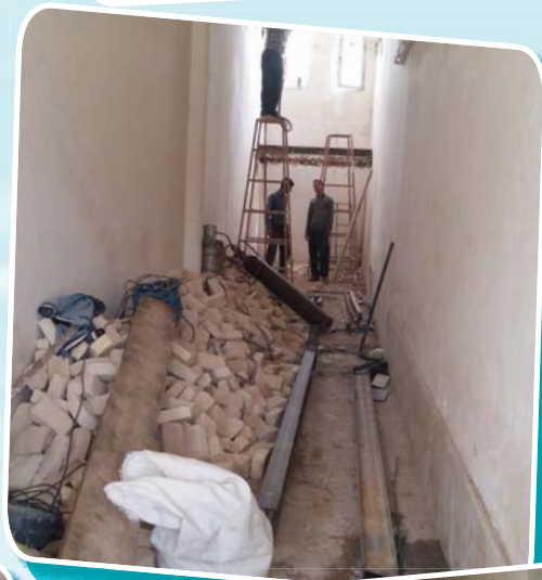
● تخریب و بازسازی ورودی به سمت بالا
