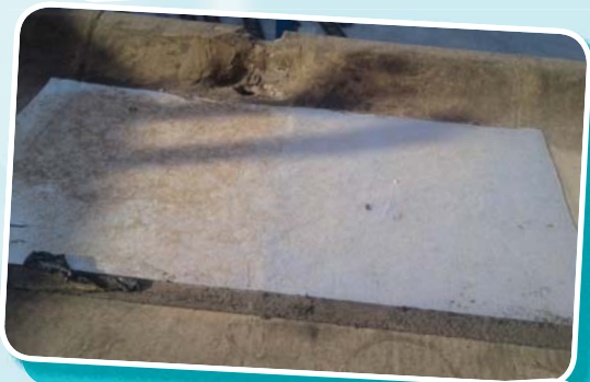
انجام ایزوگام و عایق کاری سقف و دیوارها
