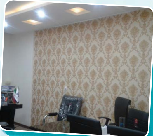
نصب کاغذ دیواری در قسمت اداری
